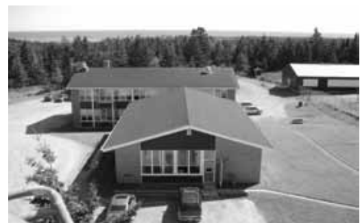
Bâtiment administratif de la Forteresse et de l'Unité de gestion du Cap-Breton. Donna MacNeil
