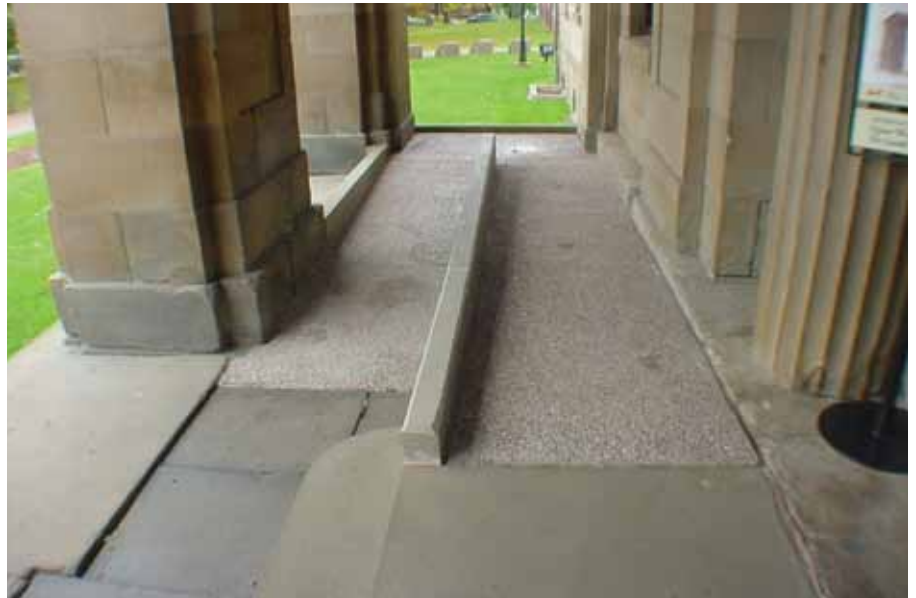
L'ajout d'une rampe pour répondre aux exigences d'accessibilité doit se faire en tenant compte de sa compatibilité avec la valeur patrimoniale du bâtiment. Cette nouvelle rampe à Province House, Charlottetown, a été discrètement intégrée dans le porche existant.
