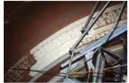
Au moment de restaurer les plâtres décoratifs du théâtre Walker de Winnipeg, des moules ont été faits des éléments décoratifs existants. Les plâtres détériorés ont alors pu être rapiécés et réparés à l'aide des moules, pour reproduire les éléments originaux.
