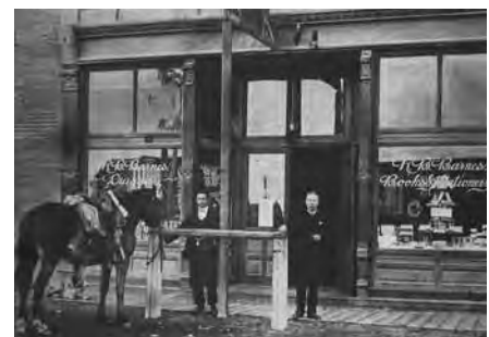
Photographie vers 1910 de la devanture de l'édifice Grier Block, baie sud. Des photographies comme celle-ci ont été des ressources indispensables lors de l'élaboration des plans de restauration de la devanture.
