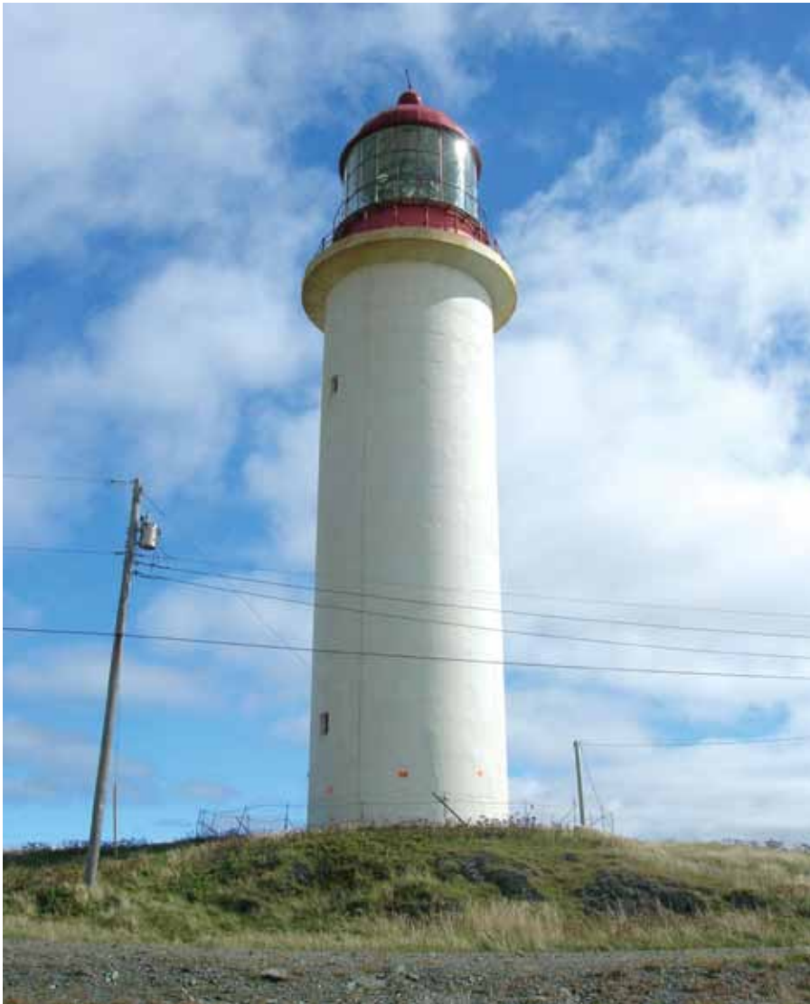
Cape Race, à la pointe sud de la péninsule d'Avalon à Terre-Neuve-et-Labrador, est le point d'arrivée à terre le plus célèbre du Canada. Construit en 1906–1907, le phare de Cape Race a été le premier phare en béton au Canada et sans doute le deuxième phare en béton armé au monde.
