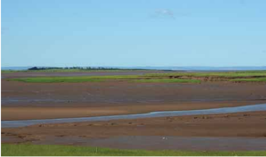
Le réseau d'évacuation des eaux et de digues en bordure des bas fonds intertidaux est un élément caractéristique de l'arrondissement historique rural de Grand-Pré.
