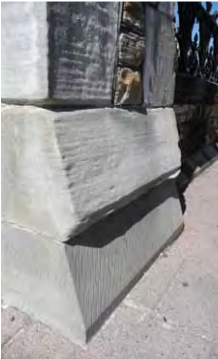
Les nouvelles pierres du mur Wellington sur les terrains du Parlement à Ottawa sont clairement visibles de près en raison de la différence dans les techniques d'outillage.
