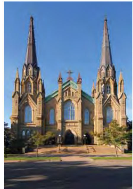
Il est important de tenir compte de la durée de vie prévue de tous les éléments qui composent le toit lorsqu'on remplace ou répare un toit comme celui de la basilique St. Dunstan de l'Île-du-Prince-Édouard. Le matériau de recouvrement, comme le cuivre ou l'ardoise, doit être appariés avec des solins d'une durée de vie similaire.
