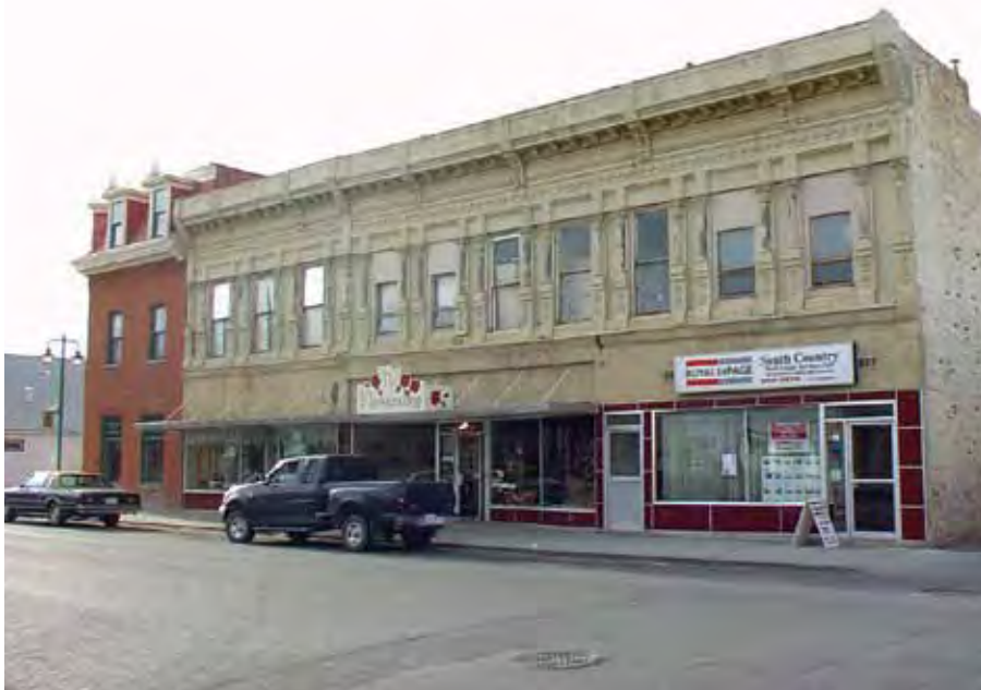
Avant la réhabilitation : façade est, en direction sud-ouest.
