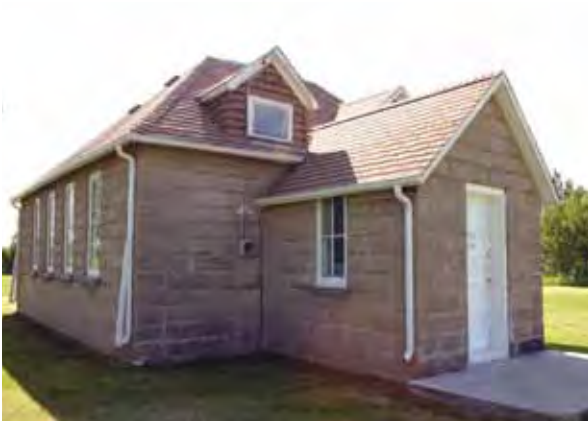
L'école Tenby de Lansdowne au Manitoba est un exemple rare et bien conservé d'école de village construite en blocs de béton, un matériau couramment utilisé entre 1890 et 1905 pour les maisons et les bâtiments commerciaux dans le sud du Manitoba. Les blocs étaient moulés sur place à l'aide de trois moules différents.
