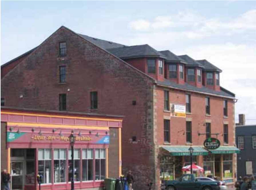
Afin d'aménager de nouvelles unités de condominiums aux étages supérieurs de ce bâtiment de la rue Queen à Charlottetown, de nouvelles lucarnes ont été ajoutées. En réhabilitation, la conception des nouveaux éléments doit être compatible avec la valeur patrimoniale du lieu.
