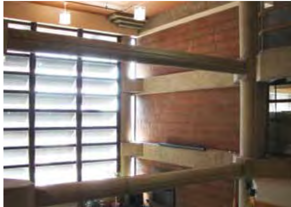
L'utilisation de la brique à l'intérieur constitue un fini durable et pratiquement indestructible dans les espaces publics. Les murs et les planchers de brique sont des éléments caractéristiques de plusieurs intérieurs modernes, comme celui de l'immeuble Joseph-Shepard de Toronto. Il n'est pas recommandé de peindre ou d'appliquer un apprêt sur la maçonnerie qui n'a jamais été recouverte dans le passé.
