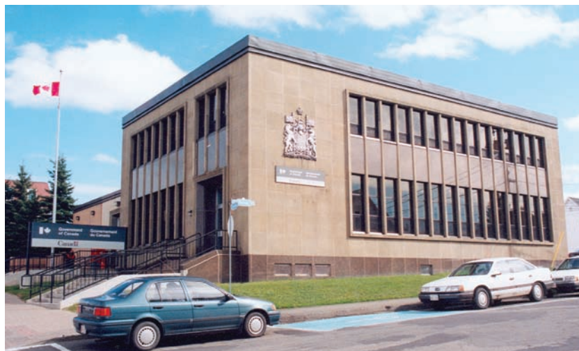
Immeuble du gouvernement du Canada Grand Falls, Nouveau-Brunswick ©TPSGC, 1999
