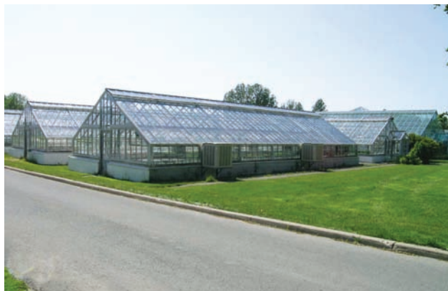
Ensemble de serres principales (bâtiment no 50) Ferme expérimentale centrale, Lieu historique national du Canada Ottawa, Ontario © C. Lefebvre, 2008
