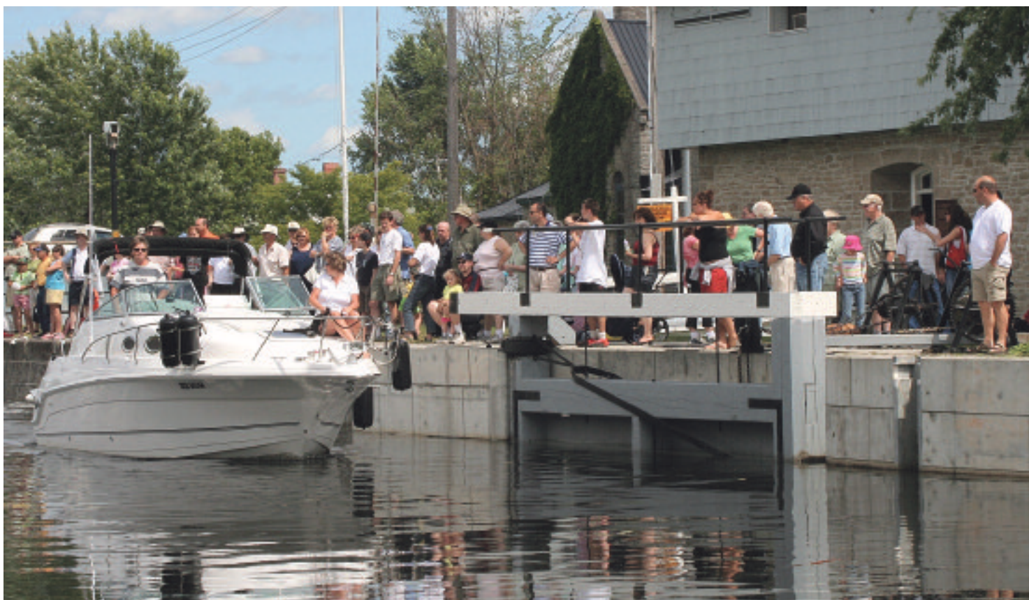
Les manœuvres d'éclusage des embarcations intéressent un grand nombre de visiteurs dans les postes d'éclusage du canal.
