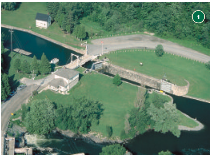
Image 1 À Lower Brewers, une centrale est érigée dans le chenal de la rivière à l'endroit où celui-ci rejoint le canal, en aval de l'écluse.
