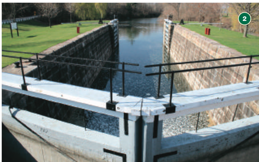
Image 2 L'écluse de Lower Brewers, dont les portes en aval sont ouvertes pour accueillir les bateaux remontant la rivière Cataraqui.
