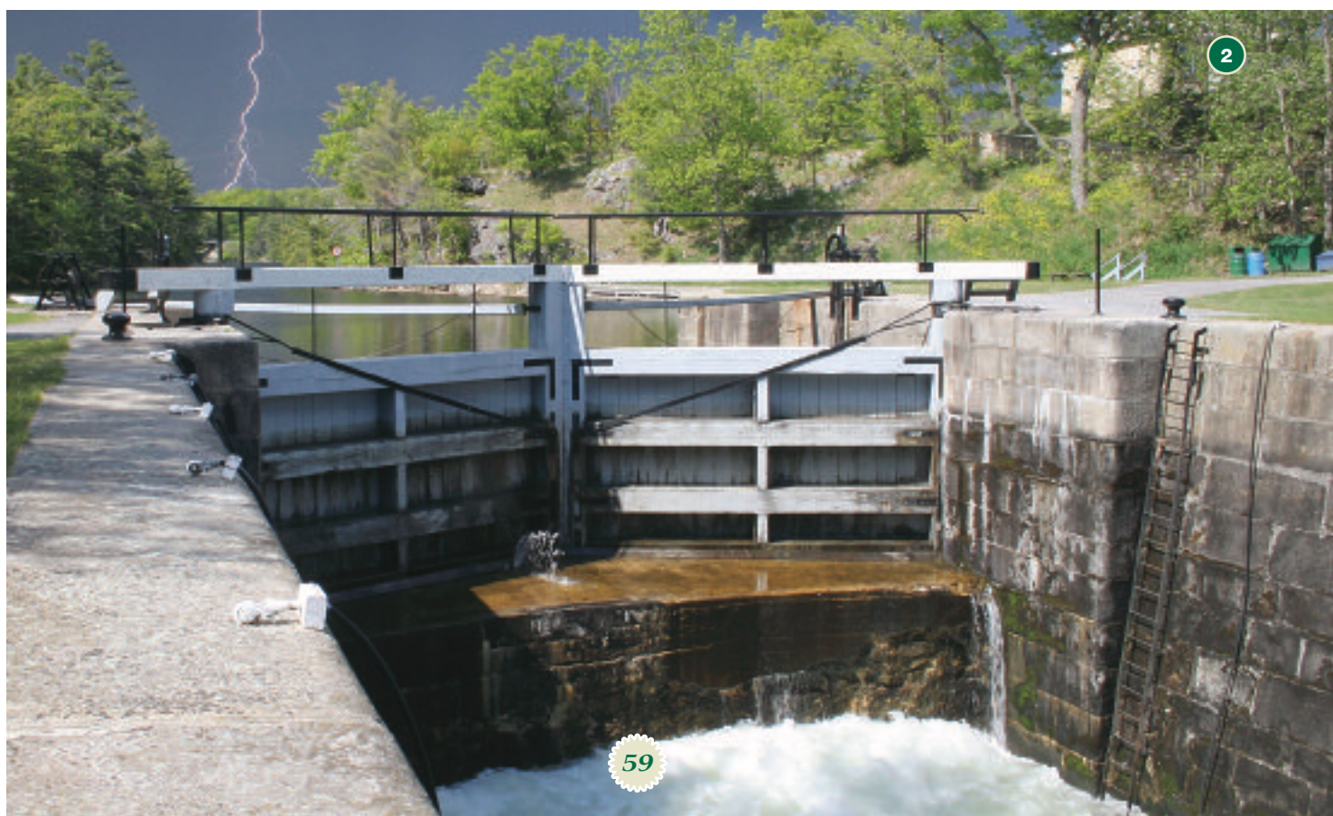
Image 2 L'écluse en amont est une structure typique avec des portes en bois et un seuil en pierre. Des vannes s'ouvrent pour laisser entrer l'eau par le fond.
