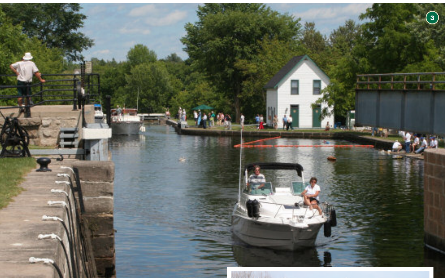
Image 3 Un pont tournant enjambe l'écluse amont qu'un bassin de virage sépare de l'écluse du milieu. Le bureau du poste d'éclusage se trouve à l'arrière-plan.
