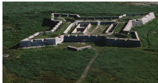
Le fort Prince-de-Galles sur la péninsule ouest / Parcs Canada
