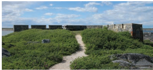
La batterie du cap Merry / Parcs Canada
